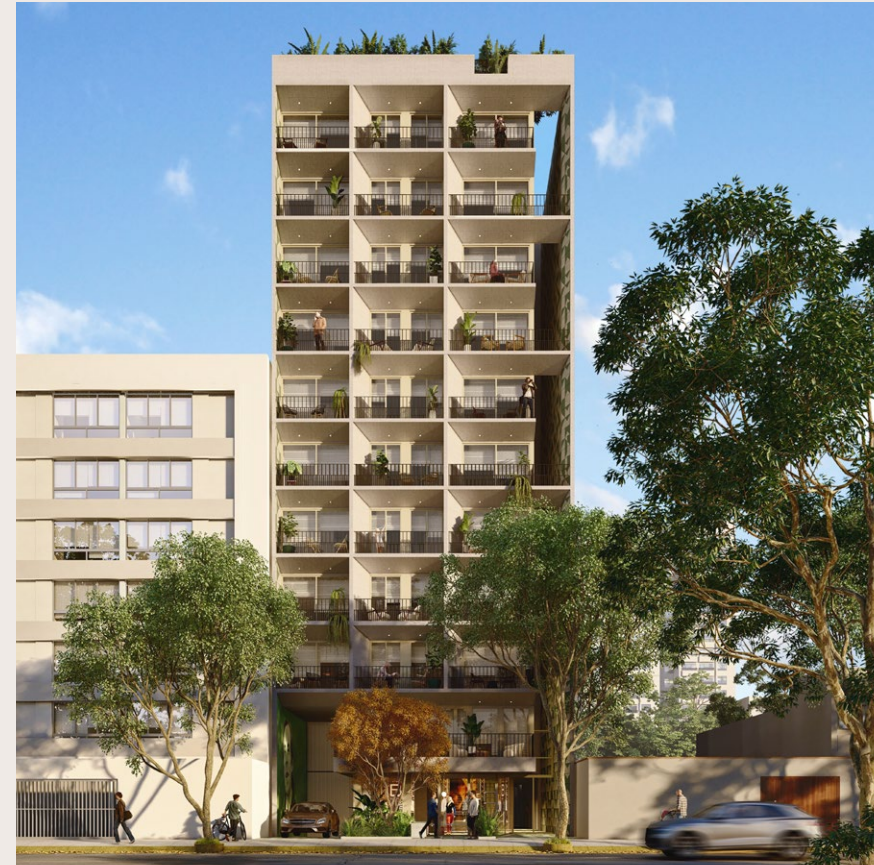
Edificio Entregado: Barrio Verde, Mediburu 573.
